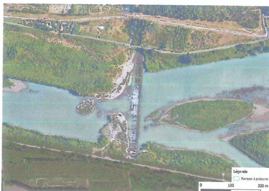
Rampe du seuil 68
