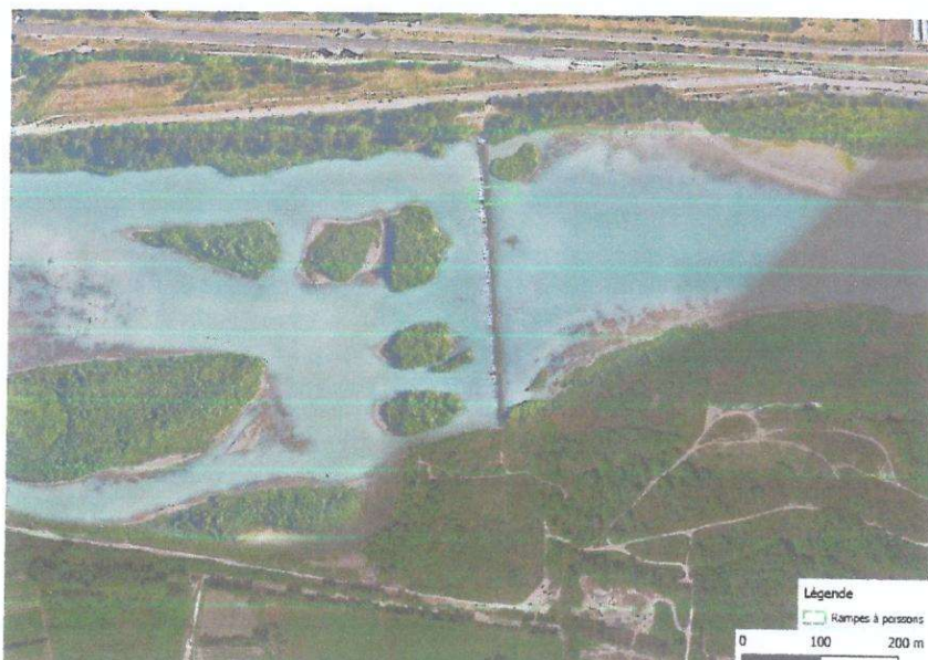
Rampe du seuil 67
